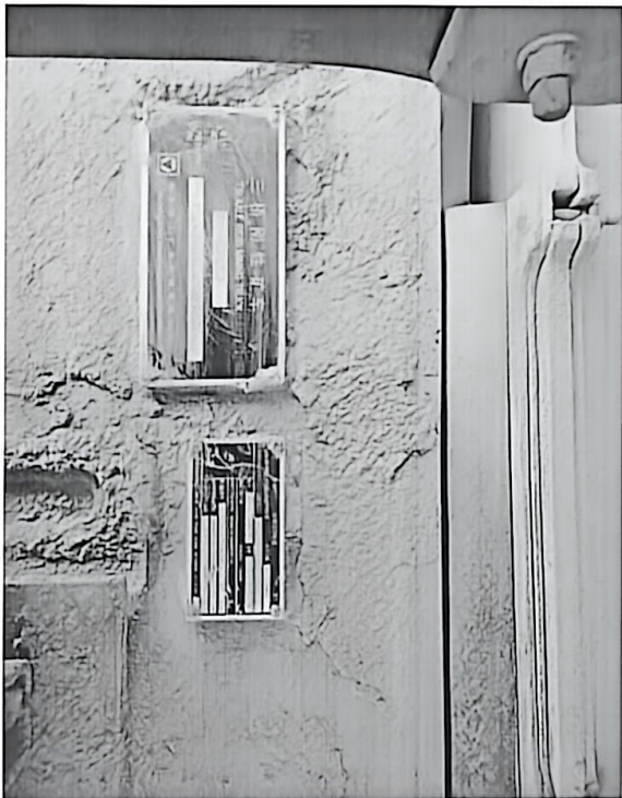
现场检验照片
