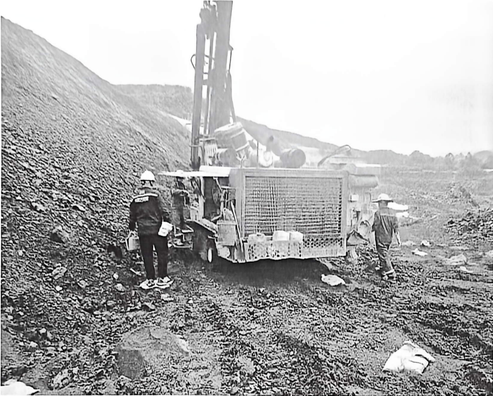
现场检验照片
